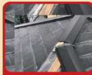
台風・雨風による飛散
