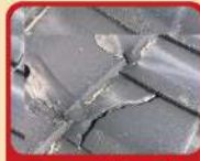
瓦のひび割れ・ずれ
