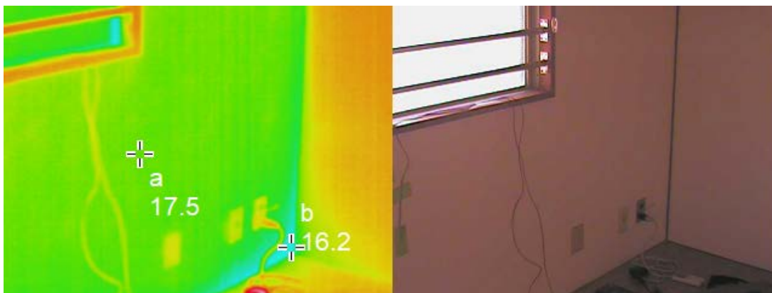
図7 302号室 東側外壁の熱画像
