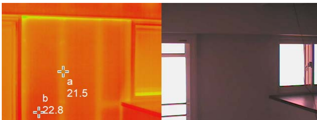
図8 502号室 東側外壁の熱画像
