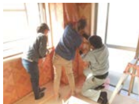
断熱を知り体験できるワークショップイベントでの施工風景。
