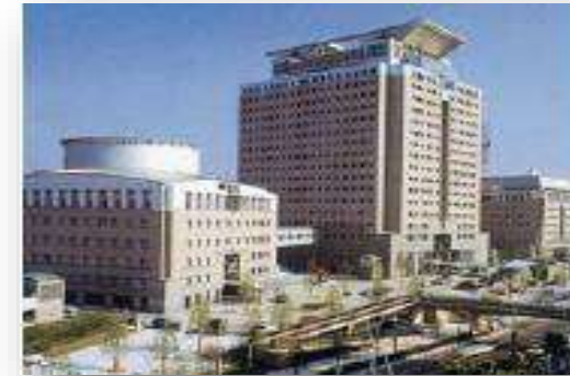
鹿児島県庁舎様（吸収式ガス空調使用）
